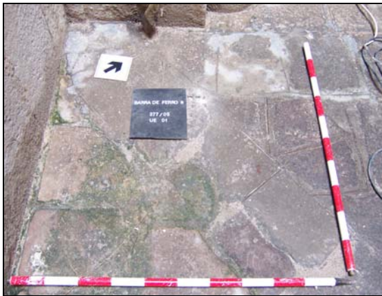
Estat inicial, paviment UE 101.
